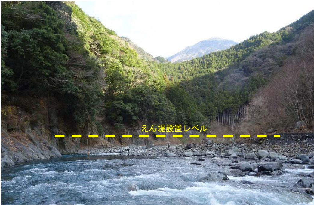
(下流側から上流側を望む)
