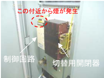
切替用開閉器の外観 (鎮火確認後に撮影)
