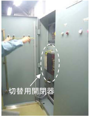
1号機照明電源切替用開閉器盤の外観 (鎮火確認後に撮影)
