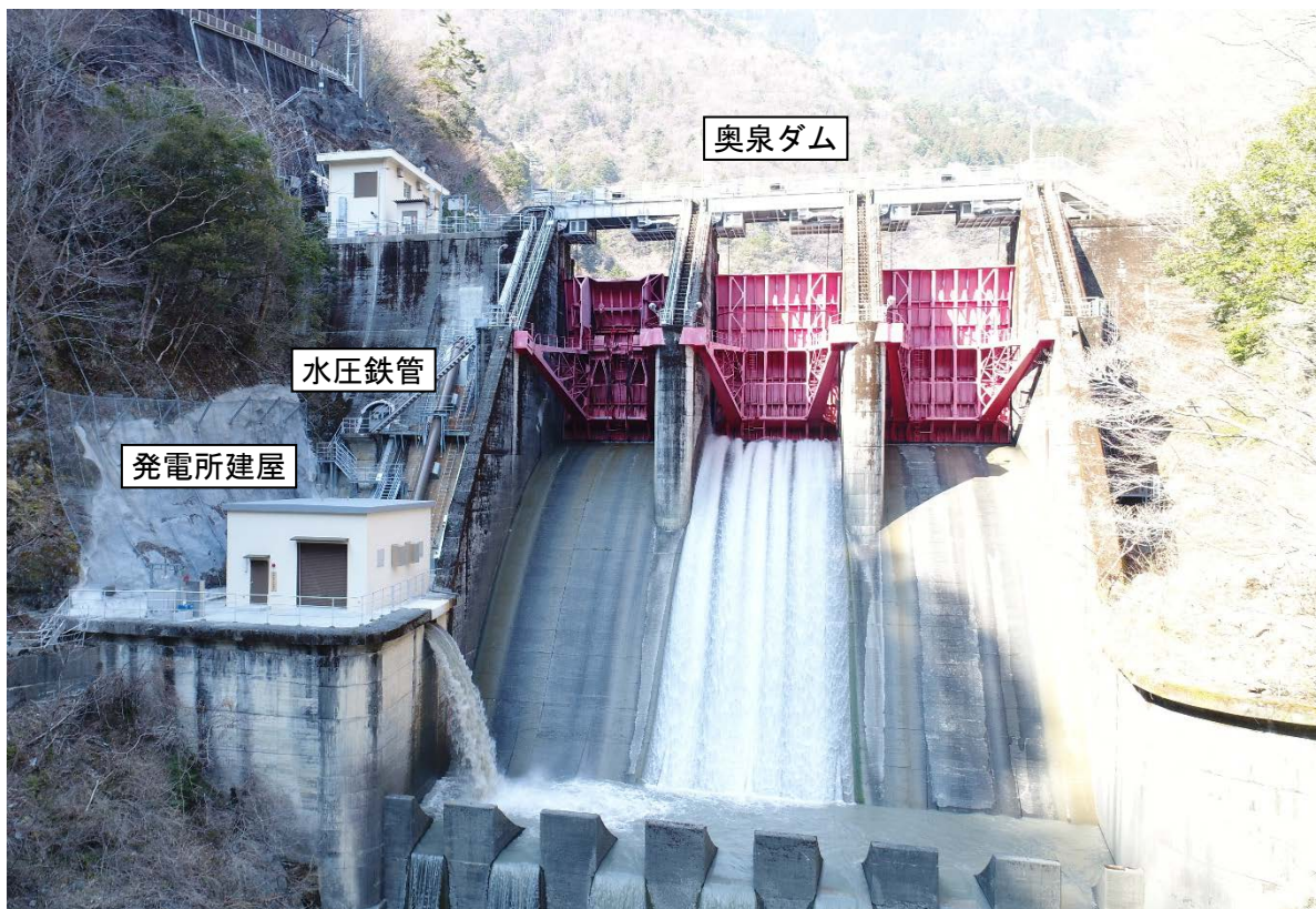
新奥泉水力発電所全景
