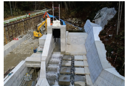
清内路水力発電所 (建設中)
