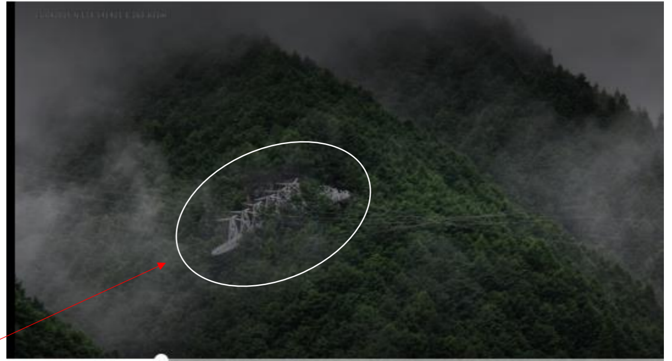
No.15 鉄塔 静岡市葵区足久保口組字八十岡地内
