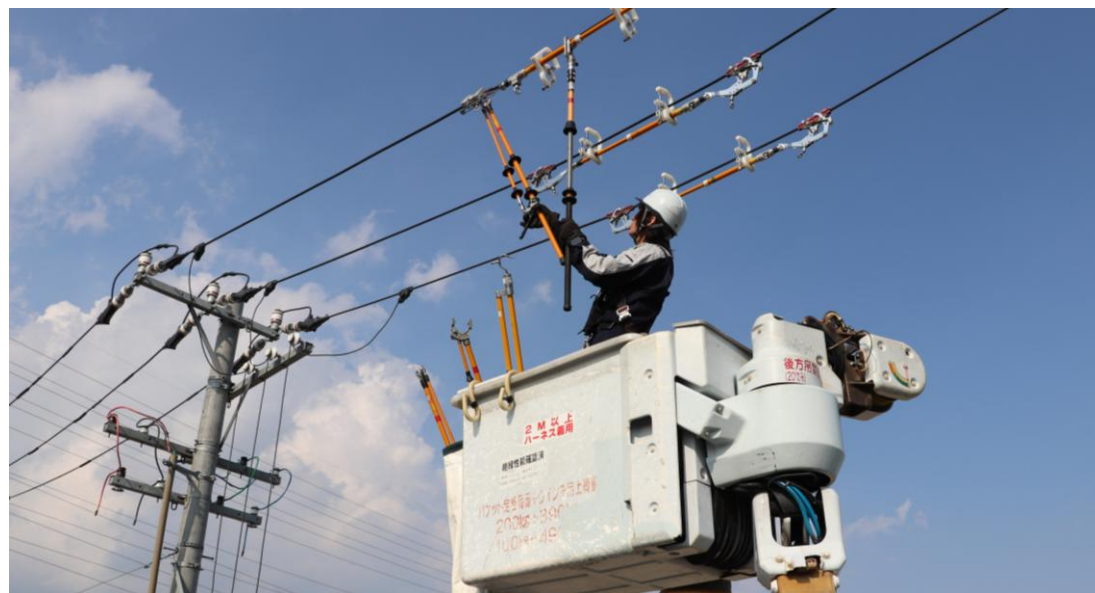
(注)写真は当社グループの株式会社トーエネックによる配電線工事の作業風景です
