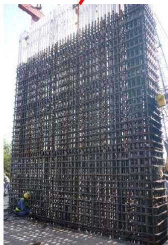
鉄筋建て込み作業
