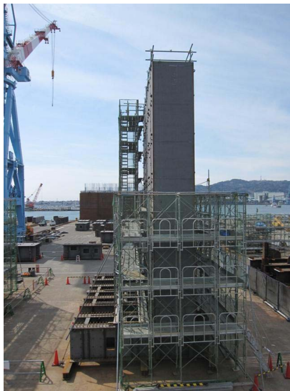
工場で仮組みした壁部(床版およびたて壁)の全景写真(1ブロック) 平成24年2月28日撮影
