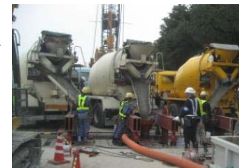
コンクリート打設作業
