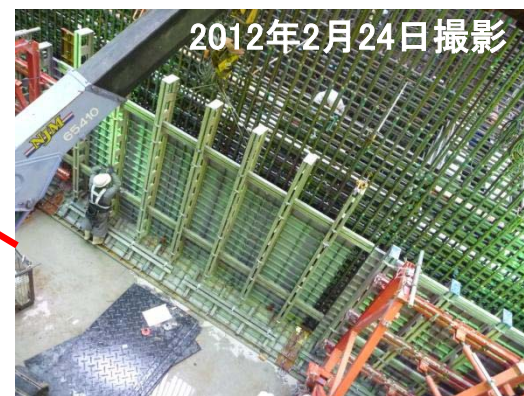
新設ポンプ室底部壁の 鉄筋組立の様子(4号機)
