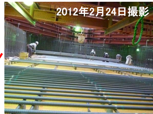
新設ポンプ室1段目中間床 壁部の鉄筋組立の様子(3号機)
