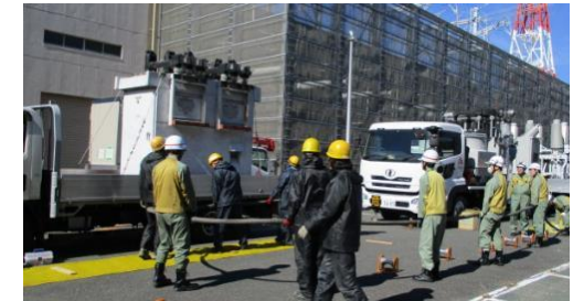
・ 発電所構内に移動用変電設備を設置する訓練
