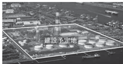
西名古屋火力発電所
