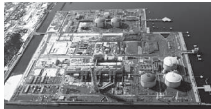
上越火力発電所建設状況(平成24年1月時点)
