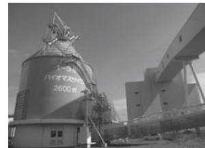
バイオマス燃料設備
