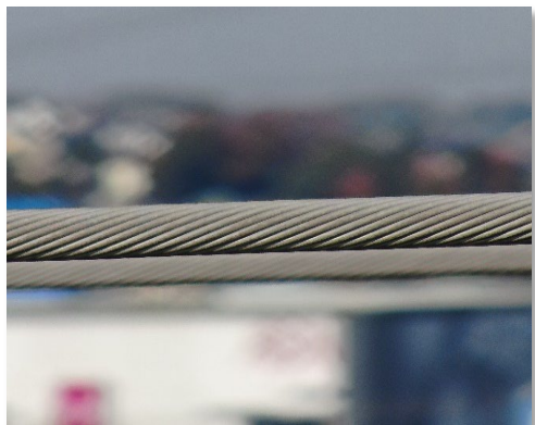
自動飛行による電線点検
