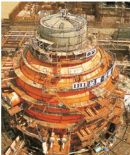
建設中の4号機原子炉格納容器
