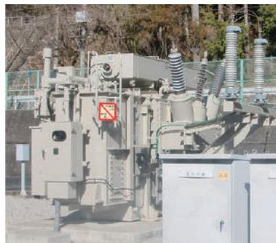
ポリマーブッシングを搭載した変圧器
