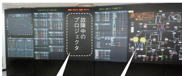
系統盤の一部が故障しても、健全なプロジェクタに代替表示できるため、重要性の高い情報を優先的に表示できる
