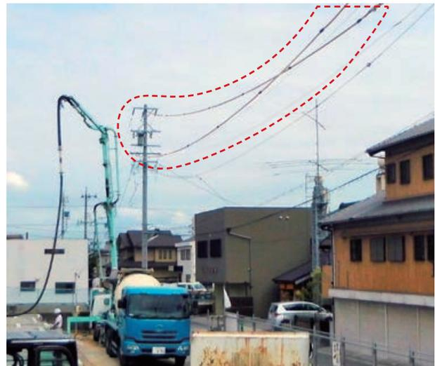
配電線に取付する防護管（赤枠部分）
