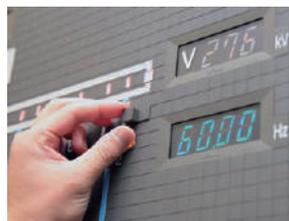
従来の固定画式系統盤 (ミニブロックと各種表示器で構成)
