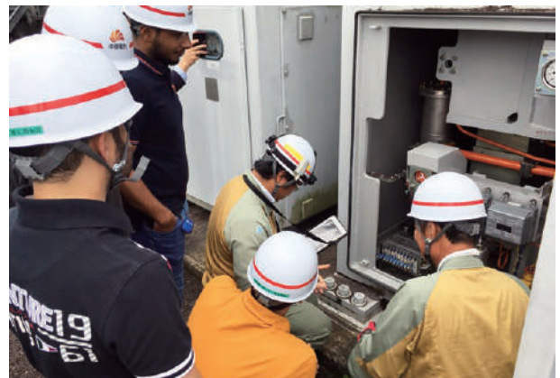
変電所巡視点検業務説明
