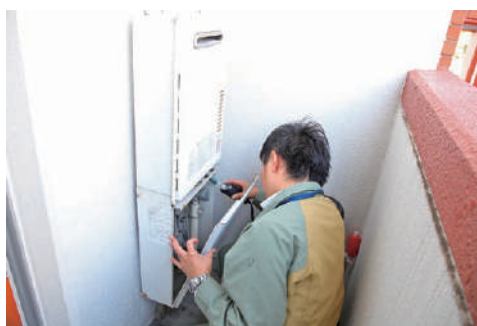
ガス営業グループ員によるガス点検作業
