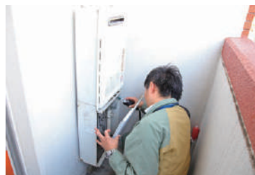
ガス営業グループ員によるガス点検作業
