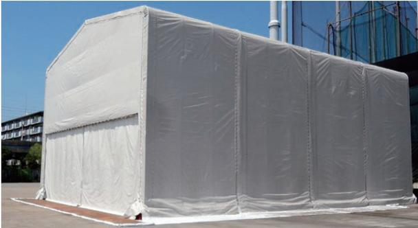
超大型変圧器現地解体用仮設囲い
