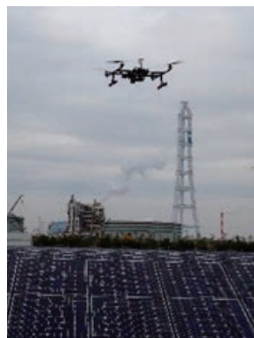
ドローンを利用したメガソーラーの点検
