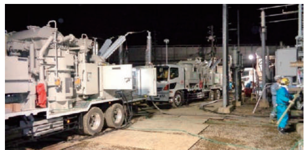
移動式変電所による仮復旧(豊野変電所)
