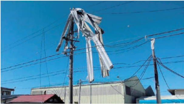
【台風 24 号】飛来物の接触による配電線の断線（静岡県浜松市）
