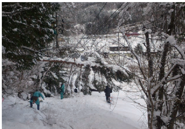
復旧作業（岐阜県高山市）
