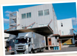
中部精機棟構内に新設された 配送センター（2013年）
