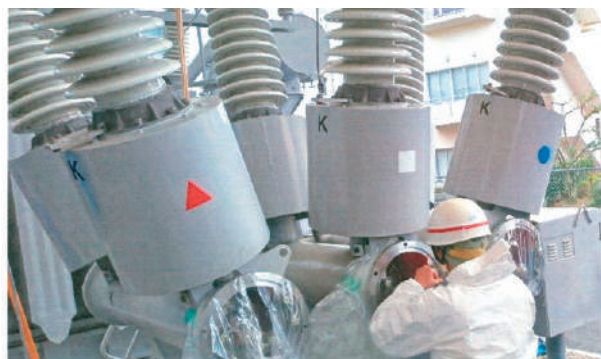
変電専門技術研修
