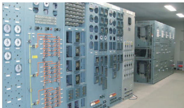
北館実習変電所
