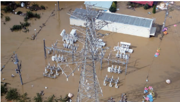
【台風 19 号】豊野変電所の浸水（長野県長野市）
