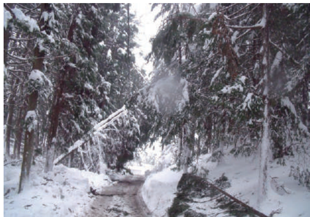
倒木による配電線の断線（岐阜県高山市）
