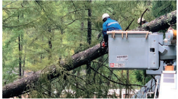
【台風 21 号】倒木撤去作業（岐阜県高山市）
