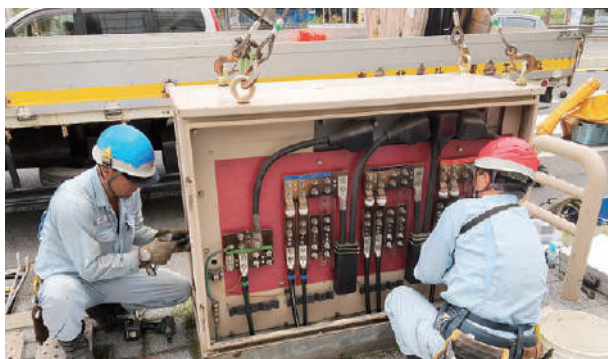
地上変圧器塔の扉を外し、同時併行作業ができるスペースを確保
