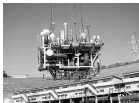
モジュールブロックの搬入状況
