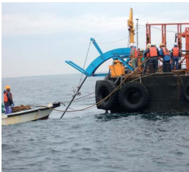
第4図 曳航布設
