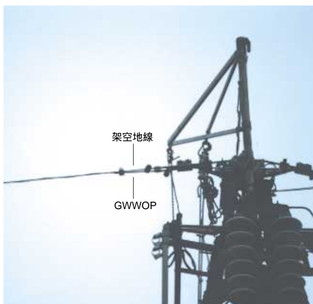
写真2 送電鉄塔頂部の巻付後の状況 (頂部には仮足場等が設置)
