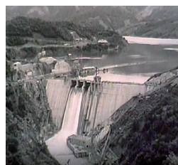
井川水力発電所(1957年)
