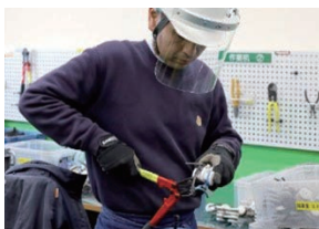
引込線解体作業
