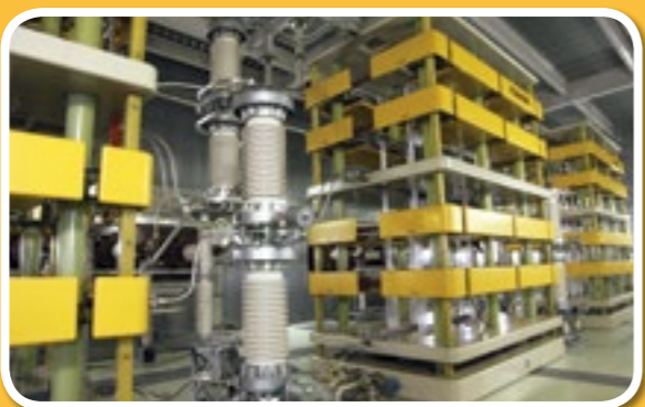
▲ 交直変換器/周波数変換所の機器の一つ。 交流と直流の変換を行う
