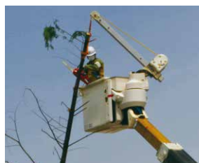
配電設備への倒木被害を想定した伐採訓練
