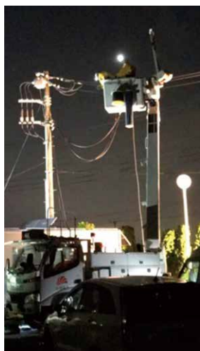
発電機車による応急送電
