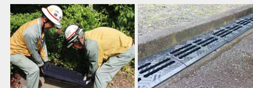
側溝用の蓋の設置
