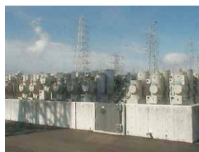
変電設備の津波対策(防水壁設置)
