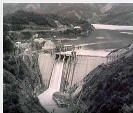
井川水力発電所 (1957年)
