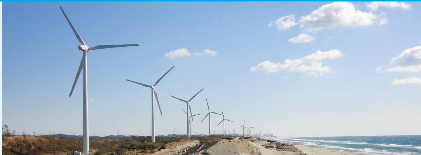
静岡県最南端の岬で11基の風車が稼働する「御前崎風力発電所」
