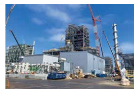
神栖バイオマス発電所 (工事状況)
