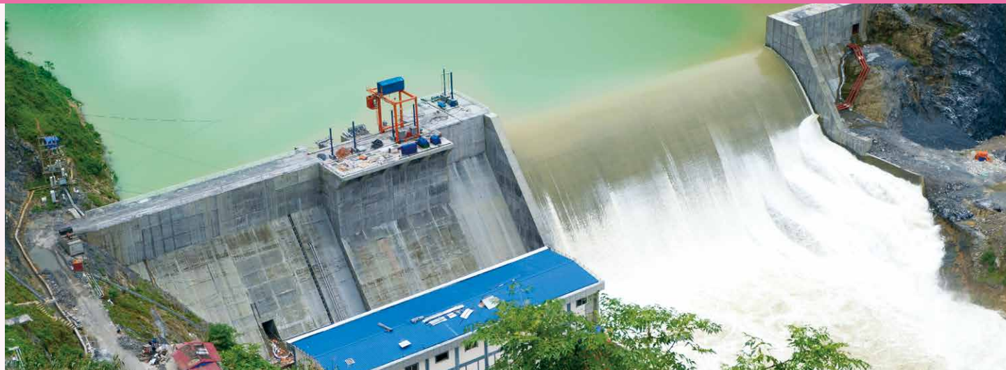
ベトナムBitexco Power Corporation社所有のNho Que 1水力発電所
