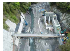
安倍川水力発電所 (えん堤工事状況)
