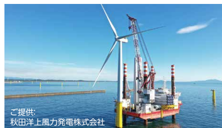
自己昇降式作業台船による風車据付工事中(能代港)
