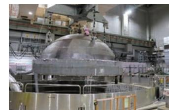
原子炉圧力容器上蓋取り外しの様子
