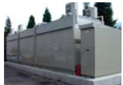
高圧大容量電気二重層キャパシタ式無停電電源装置
