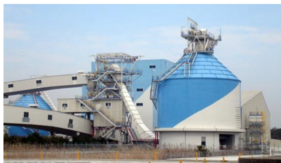
バイオマス燃料設備(碧南火力発電所)
