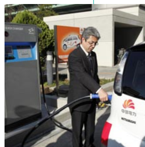
名古屋支店に設置した急速充電器
