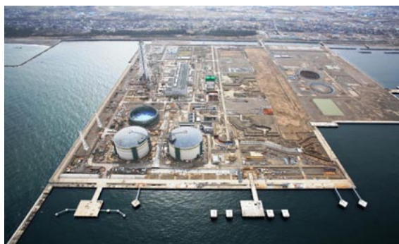
上越火力発電所建設状況(2010年3月時点)
