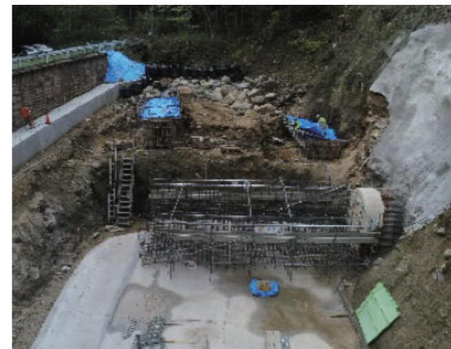
▲清内路水力発電所 小黒川えん堤 建設状況
