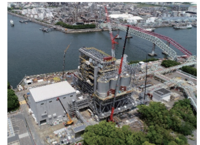
▲四日市バイオマス発電所 建設全景
