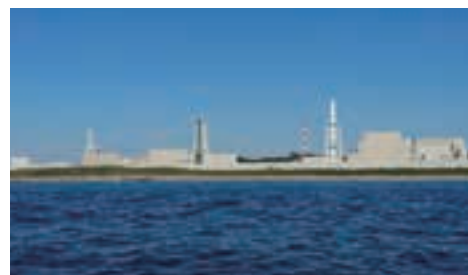
浜岡原子力発電所
