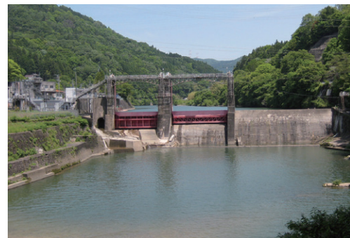
発電用に水を貯めるダム
