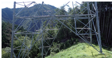
地域性に配慮した在来種のみで鉄塔下を緑化 (確実な緑化を目指しモニタリング調査を実施中)
