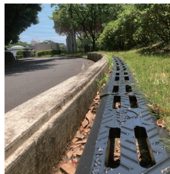
浜岡原子力発電所敷地内の側溝用蓋として再利用
