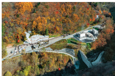
中尾地熱発電所 全景
