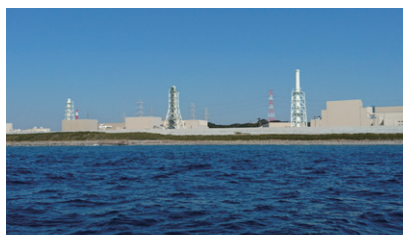
浜岡原子力発電所
