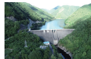
高根第二ダム
