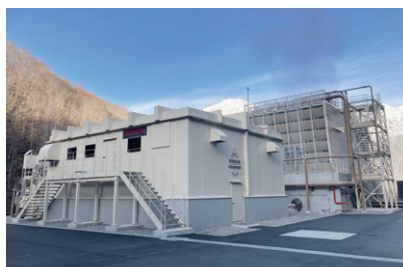
中尾地熱発電所
