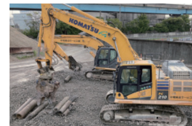
使用済み電柱の循環利用
