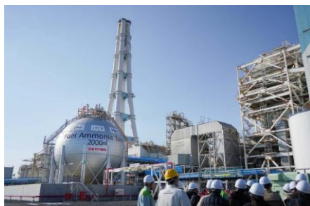
株式会社JERA提供 碧南火力発電所アンモニアタンク
