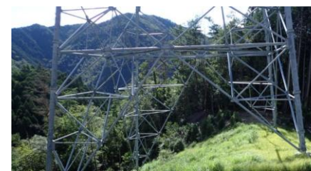
地域性に配慮した在来種のみで鉄塔下を緑化
