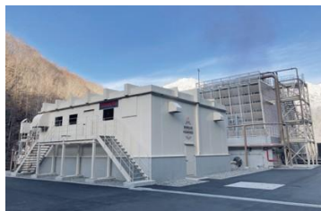
中尾地熱発電所
