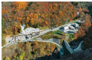
中尾地熱発電所 全景
