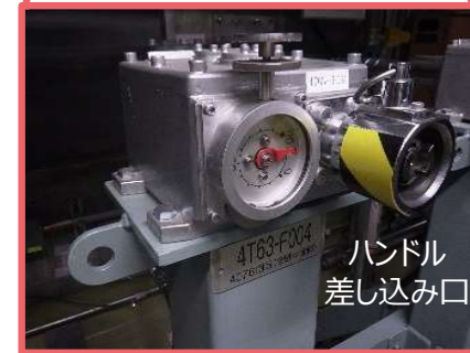
クランクハンドルまたは電動工具を接続し操作実施
