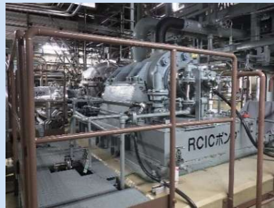
高圧注水設備 （タービン駆動）
