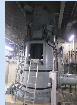
低圧注水設備（モータ駆動）
