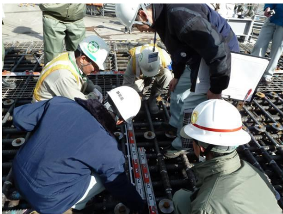
防波壁基礎部(鉄筋かご)の点検の様子
