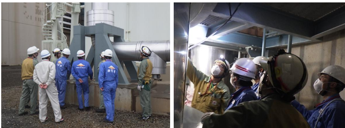
フィルタベント設備の設置工事 点検の様子
