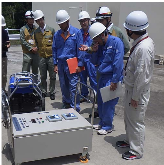
フィルタベント設備 pH 測定装置のうち可搬型装置の点検の様子
