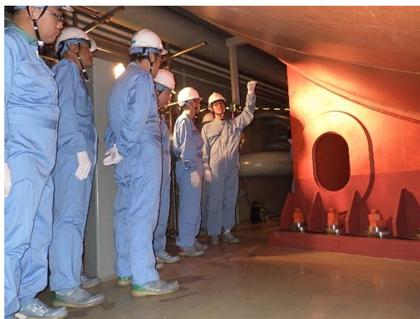
サブプレッションチェンバボックスサポート耐震補強状況確認の様子
