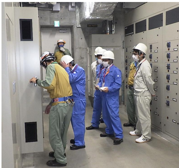
安全パラメータ伝送システム改造工事 点検の様子
