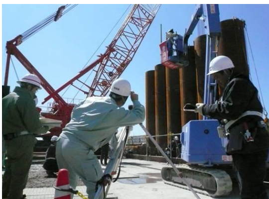
防波壁基礎部(鋼管矢板形状)点検の様子
