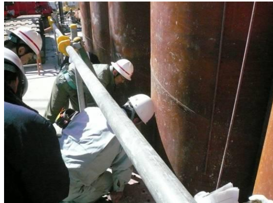
防波壁基礎部(鋼管矢板形状)点検の様子
