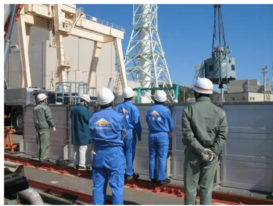
原子炉機器冷却海水系電動機取り替え訓練の様子
