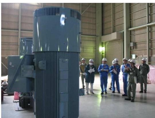
原子炉機器冷却海水系の予備品確認の様子
