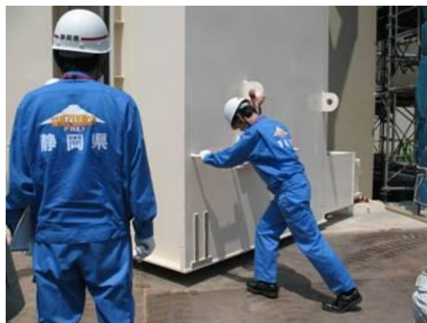
防水構造扉の信頼性強化に関する点検の様子
