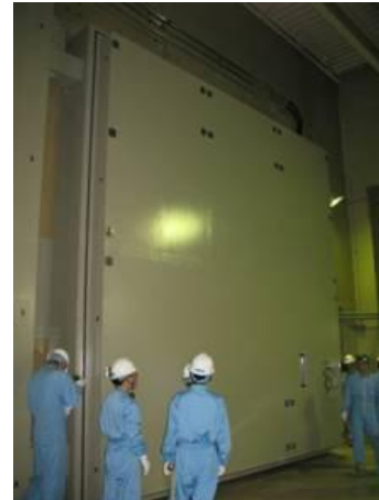
水密扉点検の様子
