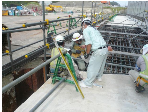
防波壁基礎部点検の様子
