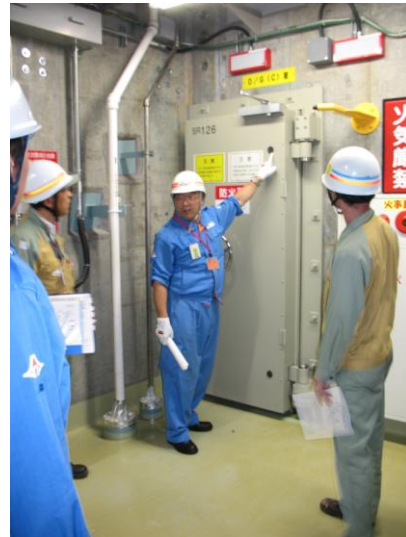
水密扉点検の様子
