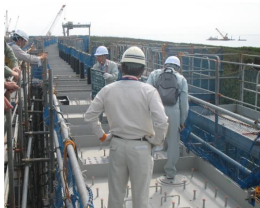
防波壁の壁部(頂部)点検の様子
