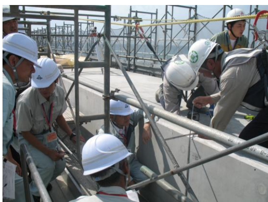
防波壁の壁部(敷地西側端部)点検の様子
