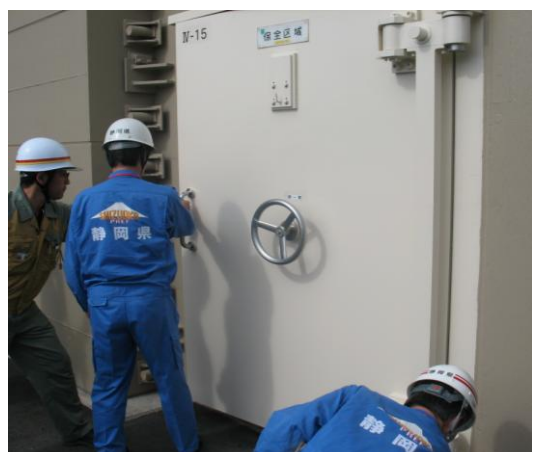
強化扉点検の様子
