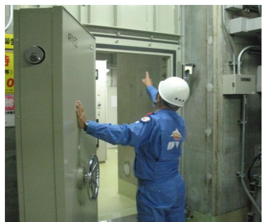
水密扉点検の様子
