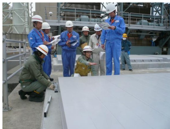
放水ピット閉止蓋の点検の様子
