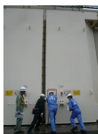
大物搬入口の外側強化扉の点検の様子
