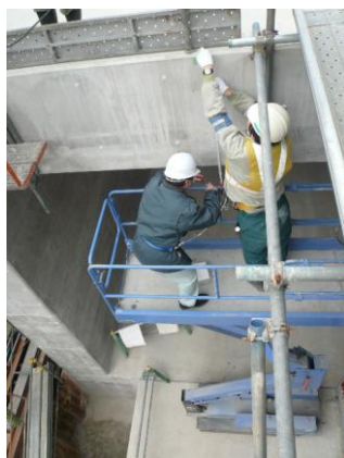
防波壁の点検の様子
