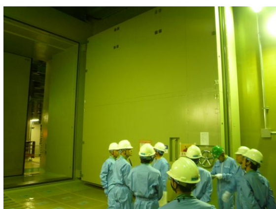
大物搬入口の内側水密扉の点検の様子
