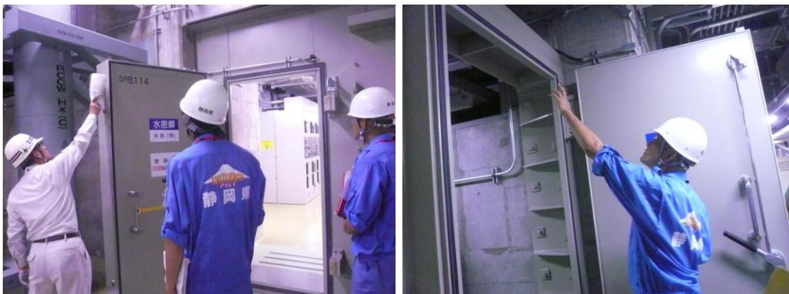
津波対策工事にて追加設置、補強した水密扉の点検の様子
