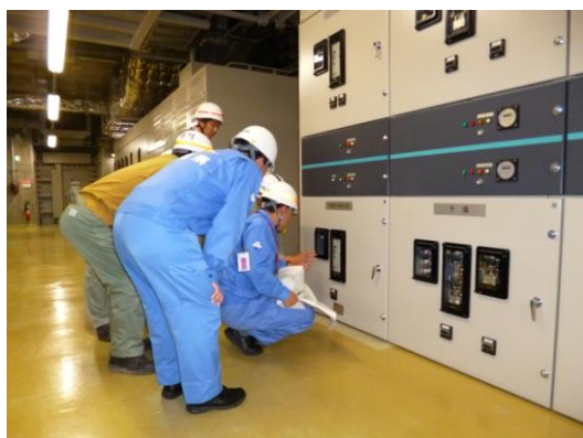
5号機受電回路(電源盤)点検の様子
