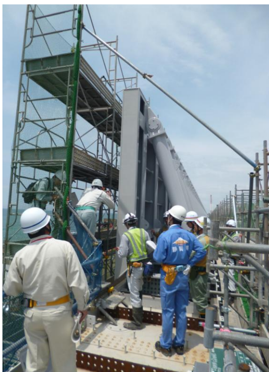
一般部壁部(継壁)点検の様子
