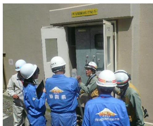
建屋外壁貫通部の止水対策点検の様子
