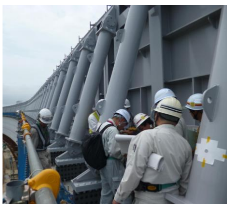
一般部壁部(継壁)点検の様子
