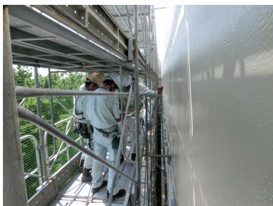
一般部壁部(継壁)点検の様子
