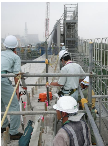
放水路部点検の様子
