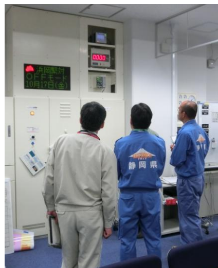
放射線エリアモニタおよび酸素濃度計の緊急時対策所への設置工事点検の様子
