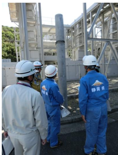
一般高圧配電線からの電力供給対策の点検の様子
