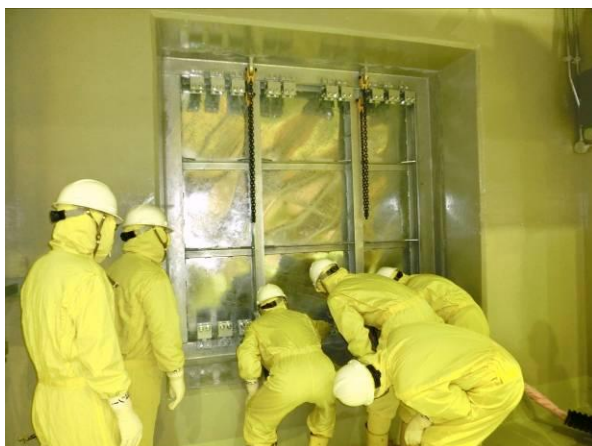
原子炉建屋ベント設備設置工事点検の様子
