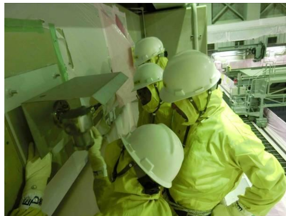
原子炉建屋への水素濃度計の設置工事点検の様子
